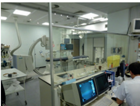
Figuur 3: Voorbeeld van een loden venster voor de console en loden gordijnen aan de tafel
